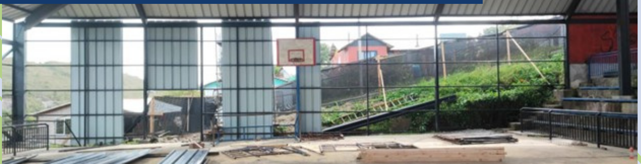
CIERRE PERIMETRAL POZO LASTRE
